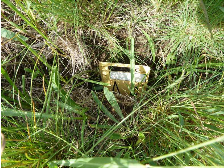
Снимка 118. Пукнатина в земната повърхност в заливната тераса на Ралевска река.
